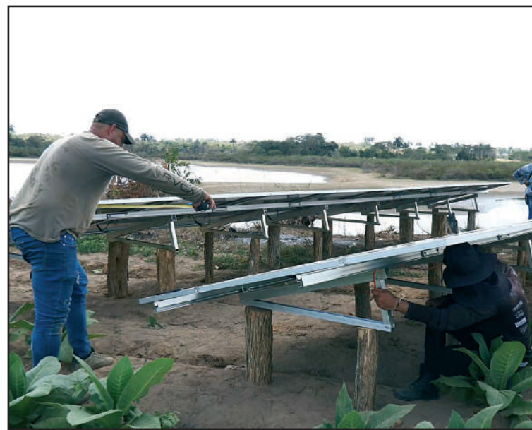
Ubicar las estructuras sobre pilotes de eucalipto es una estrategia frente a la carencia de áridos y otros productos necesarios para la conformación de postes de hormigón
