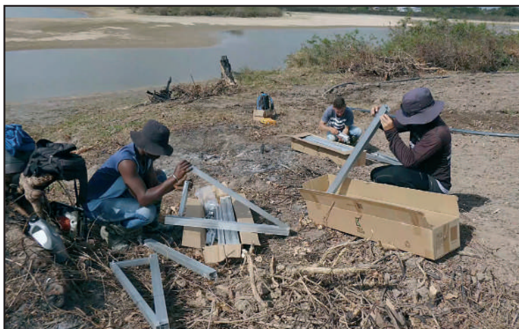
El montaje de los paneles y los sistemas fotovoltaicos por los jóvenes de PlasticArte está certificado por los proveedores y cuenta con capacitación constante por parte de la Empresa
