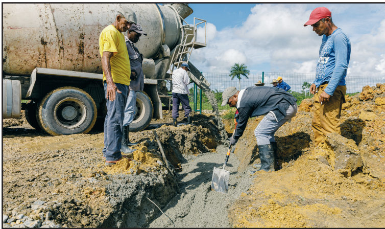
Brigadas de la Empresa de Construcción y Montaje y la Constructora Militar llevaron a cabo la obra civil del emplazamiento
