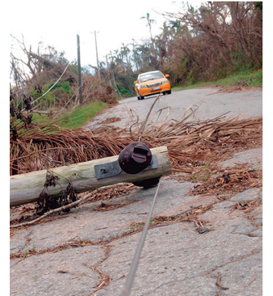
El tendido eléctrico fue fuertemente dañado
