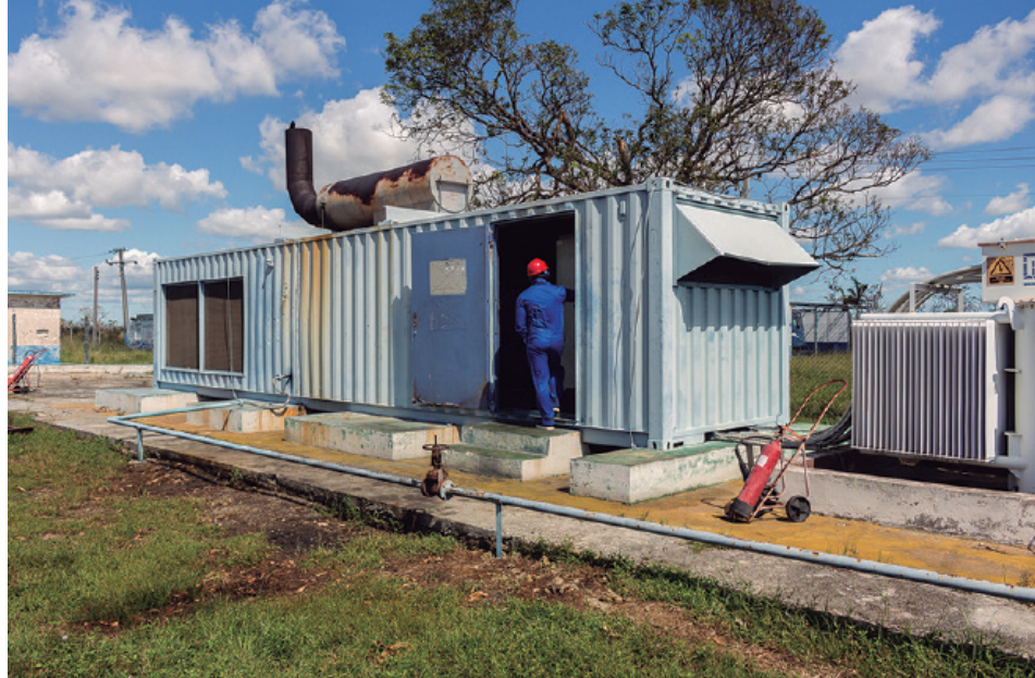
En tiempos normales el grupo electrógeno se mantiene sincronizado constantemente al Sistema Electroenergético Nacional
