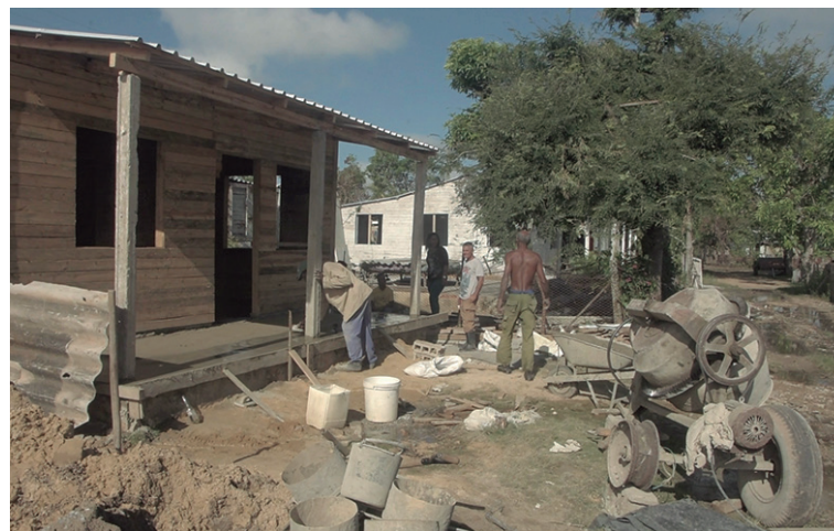
El movimiento constructivo que hay en El Sitio no tiene precedentes en esa comunidad
