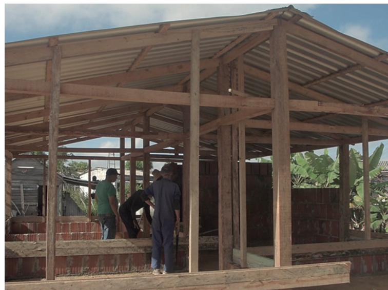
Más de 20 viviendas de tipología IV se encuentran en distintas fases de ejecución
