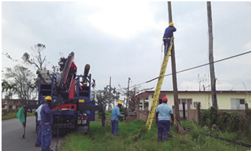
Levantar líneas y postes han sido las principales acciones de esta brigada de Etecsa de La Habana
