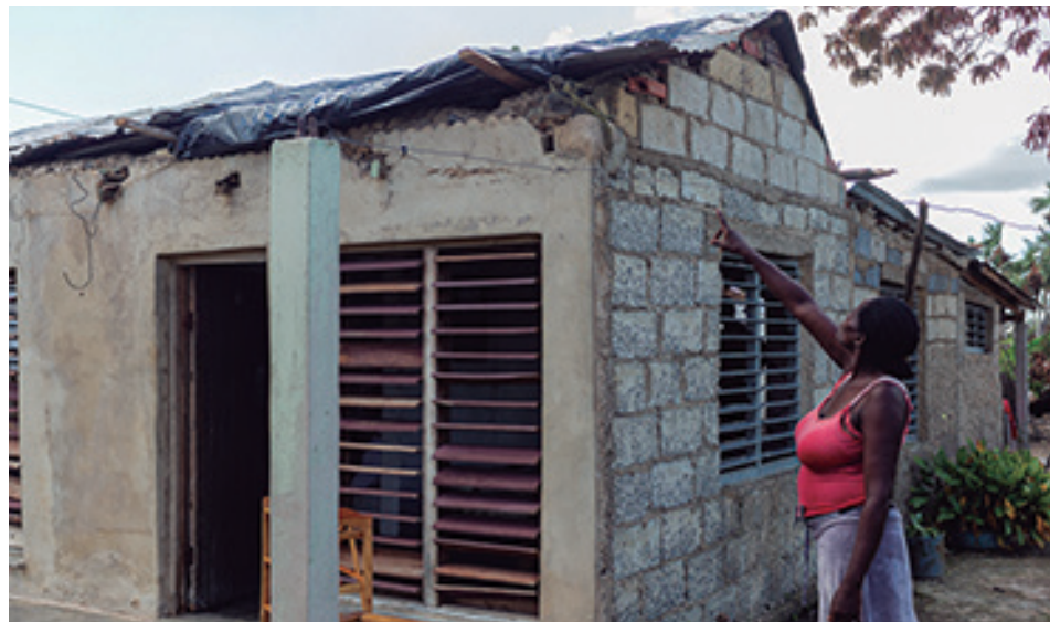
Arais Valdés León señala los daños que Ian provocó en su vivienda
