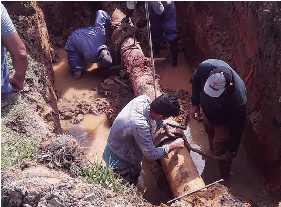
La puesta en marcha del sistema de abasto de Herradura, en Consolación del Sur, con 500 metros de conductora de PEAD, garantiza una mejora en los ciclos de distribución en los puntos altos y finales de las redes. Foto tomada del perfil de la Empresa de Acueducto y Alcantarillado de Pinar del Río
