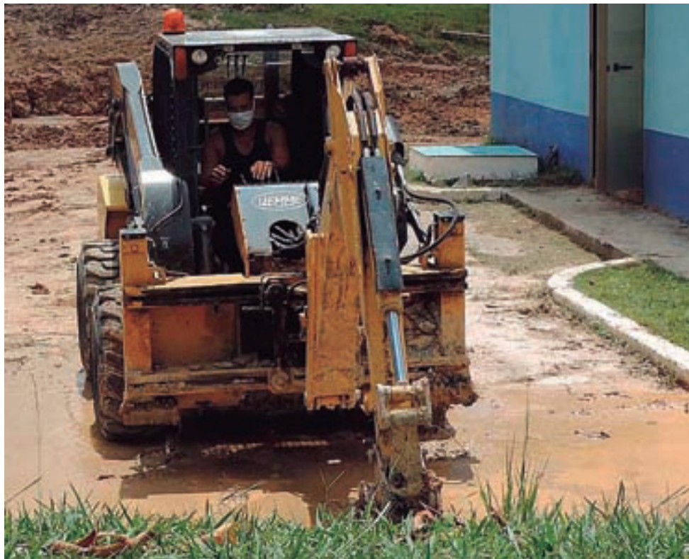
Las acciones constructivas ejecutadas en la planta potabilizadora de Viñales permiten realizar la entrega con mayor presión, mejorar la calidad del agua y las condiciones para los trabajadores en las instalaciones
