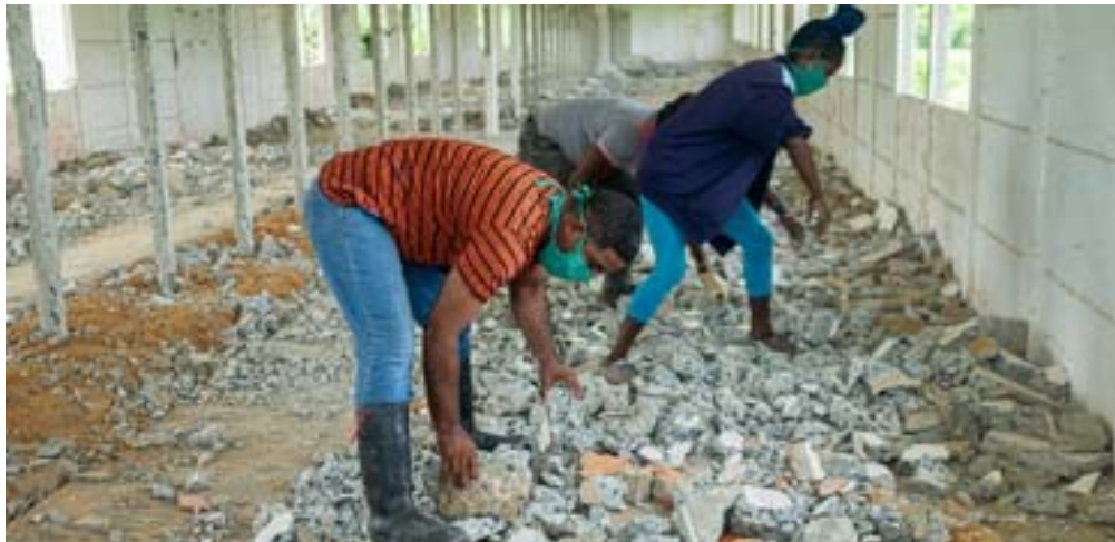
Una de las labores más duras es el desmontaje de las viejas paredes y la carga de escombros
