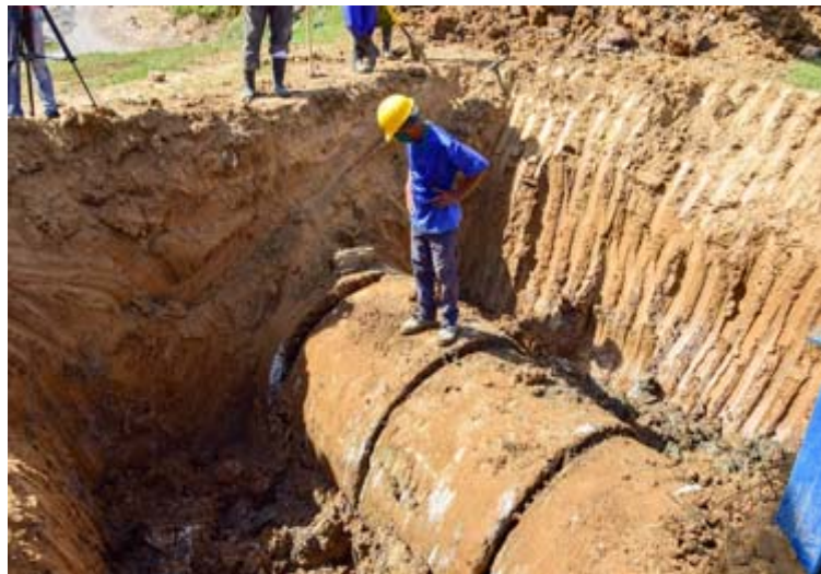
Acción de mantenimiento en la derivadora Madre Vieja
