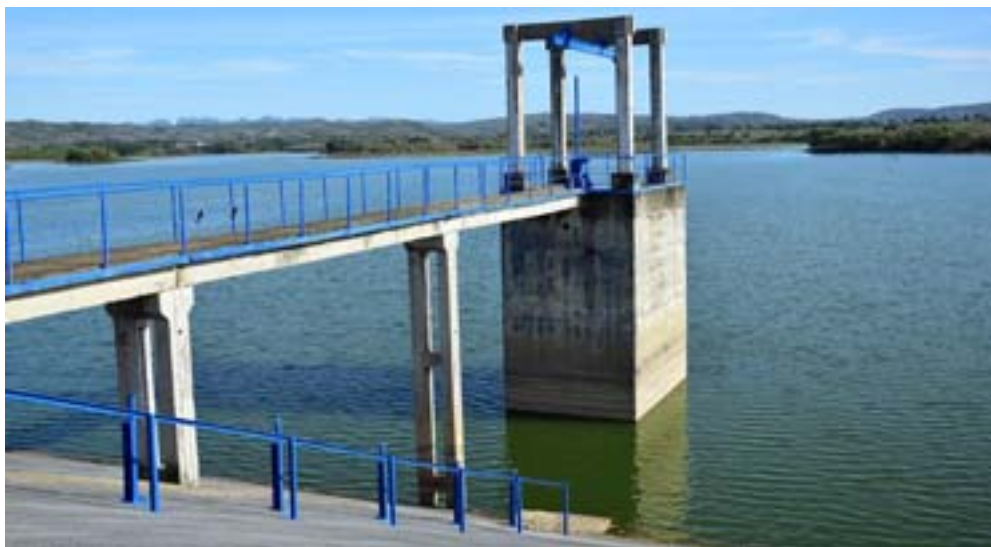
La presa Paso Viejo, ubicada a siete kilómetros al norte de la ciudad de Pinar del Río, se halla al 75 por ciento de su capacidad de llenado
