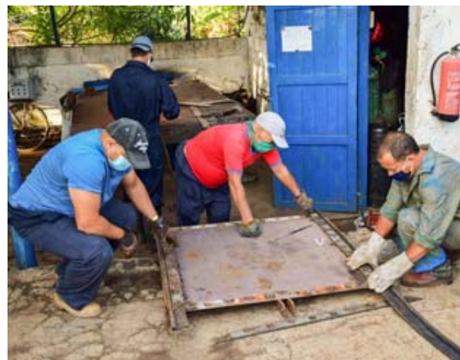
Trabajadores de la brigada electromecánica confeccionan unas compuertas para el canal Herradura-San Diego
