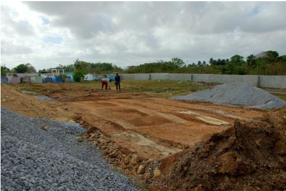
En el Cementerio Municipal se preparaban los terrenos para la construcción de los nichos
