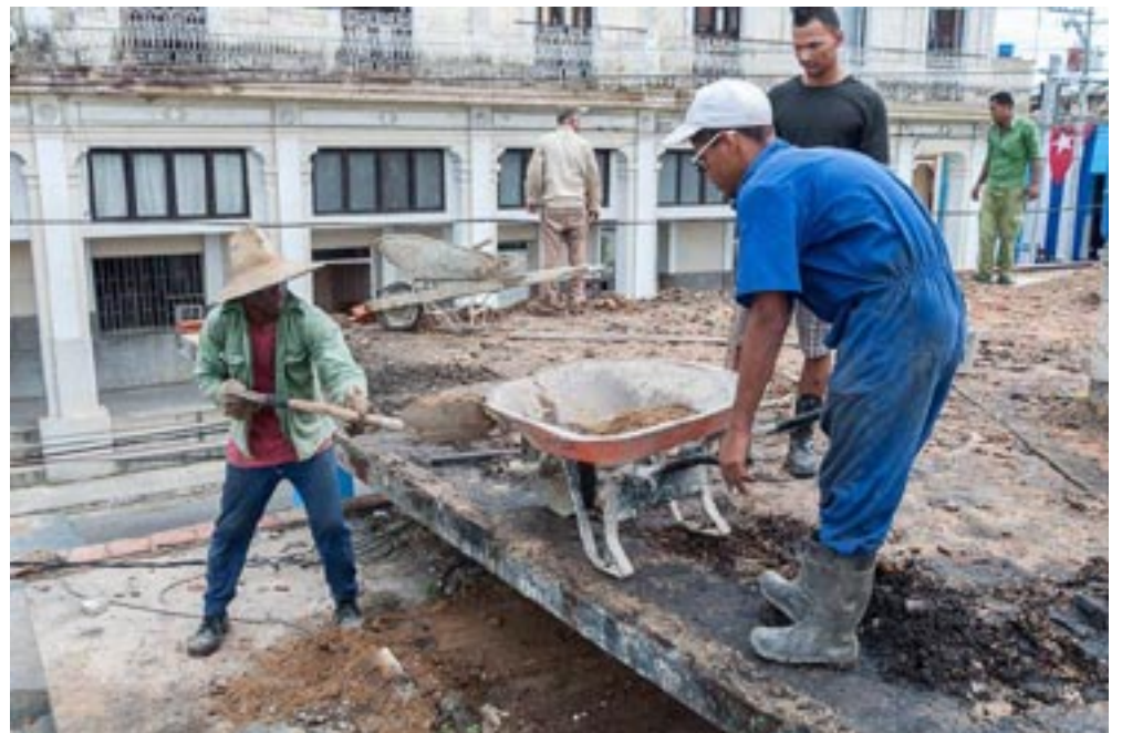
El restaurante El Marino recibió un impulso en la reparación de su cubierta
