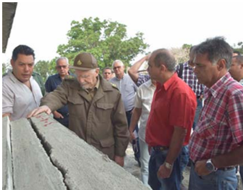
El el Centro de Producción Local de Materiales para la Construcción del municipio de Pinar del Río, Valdés Menéndez cuestionó el flujo productivo y el acabado de los elementos prefabricados
