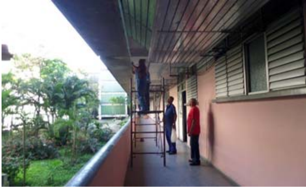
Comienza la colocación de los falso techos metálicos para el sistema de pasillos del hospital
